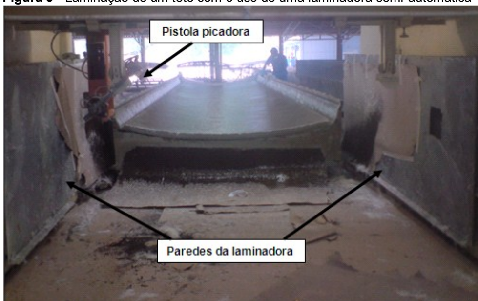
Figura 3 - Laminação de um teto com o uso de uma laminadora semi-automática
