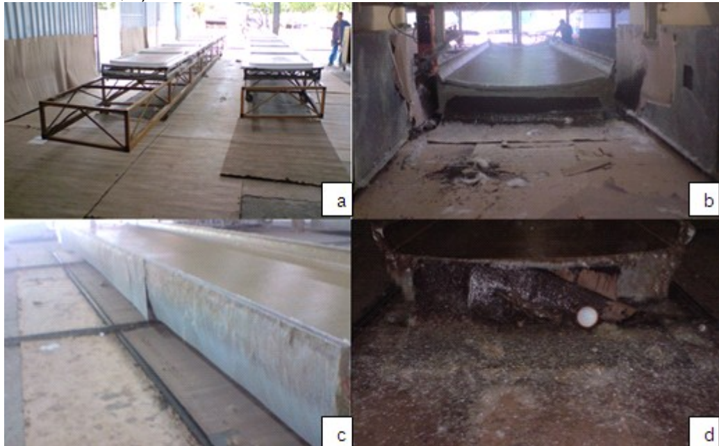
Figura 4 - Uso de papelão na moldagem dos tetos e entre-janelas: a) piso e paredes - entre-janelas; b) piso e paredes da laminadora – tetos c) piso sob e em volta do molde do teto; d) frente do molde do teto
