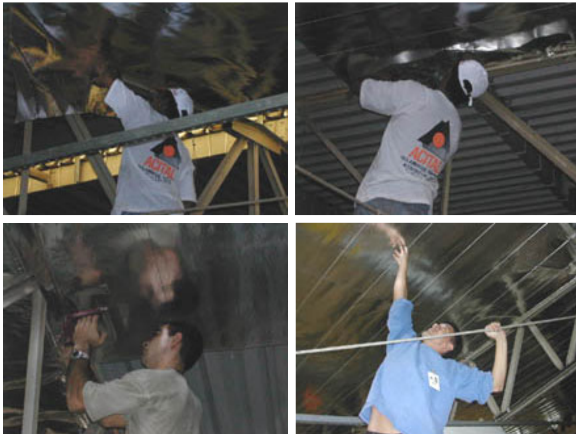
Figuras 1, 2, 3 e 4 – Procedimento de instalação e verificação da colocação do forro térmico.
