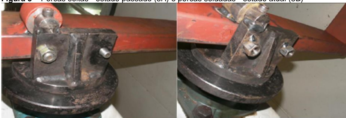
Figura 5 – Porcas soltas - estado passado (5A) e porcas soldadas - estado atual (5B)
