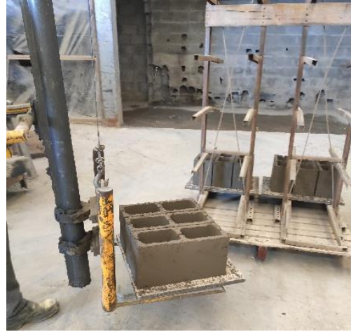
Figura 9 – Colocação do material no cavalete
