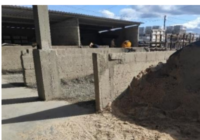
Figura 5 – Baias dos agregados
