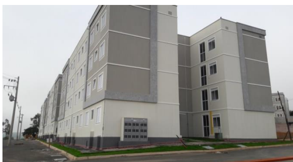
Figura 3 e 4 - Local da obra da empresa 7
